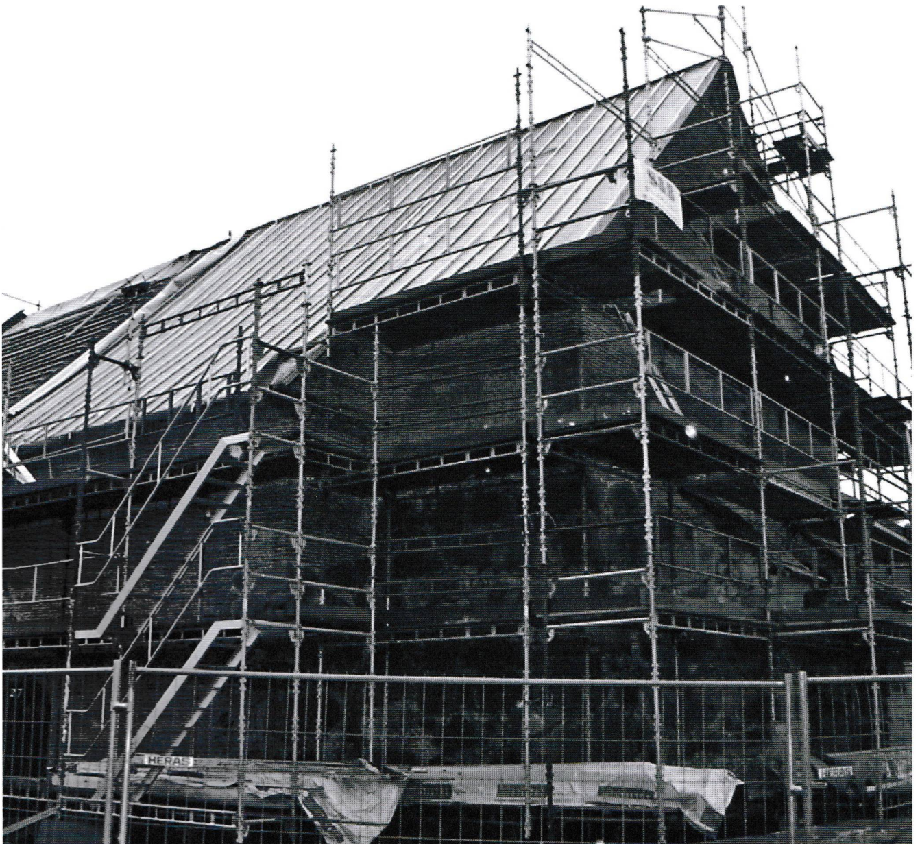
Krutthuset på Verftet er et av de største prosjektene hvor restaurering nå fullføres.
