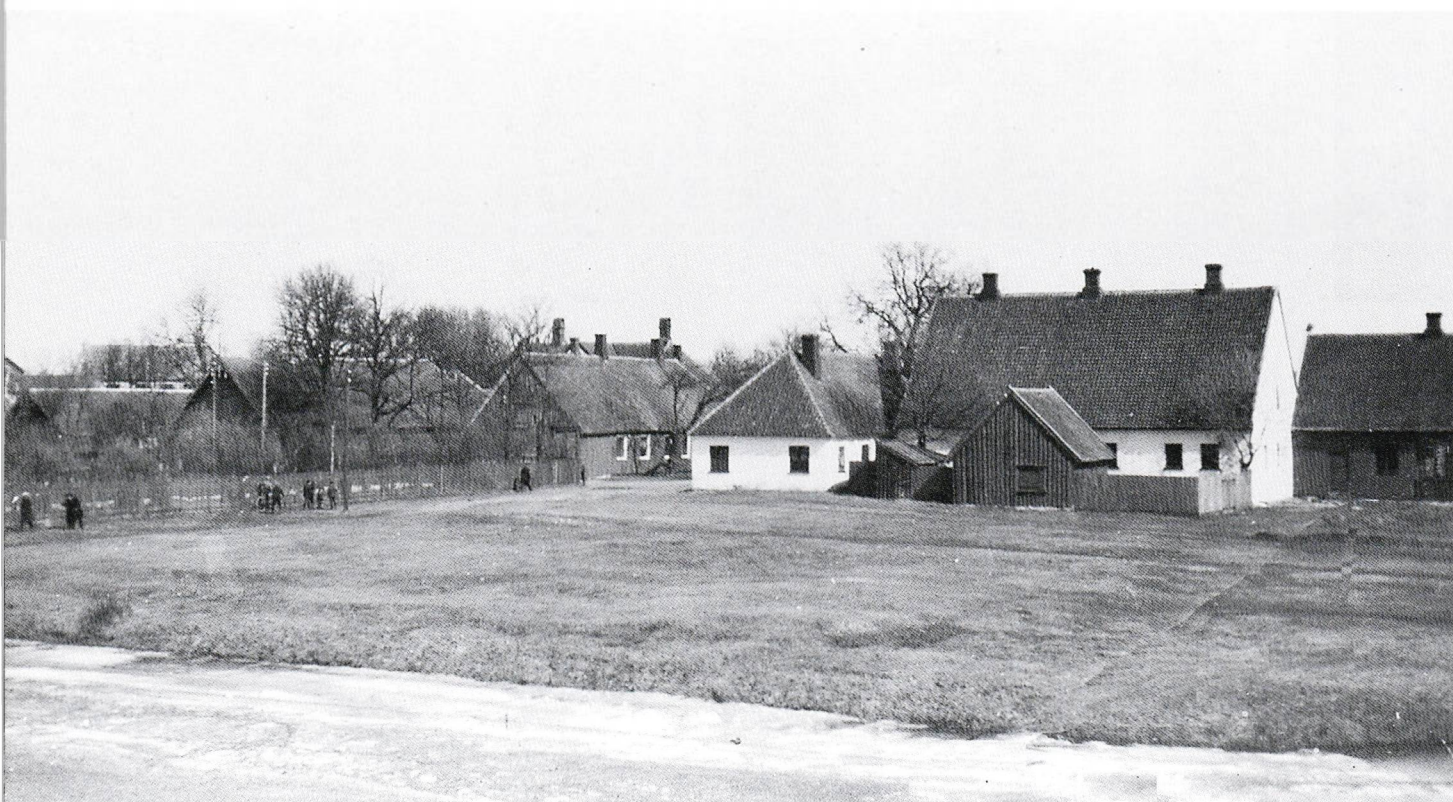
Denne delen av bebyggelsen på Verftet kunne man tenke seg å overlate til Fortidsminnemerkeforeningen, eller til annet kulturelt bruk – skipsverftsindustrien var ihvertfall ikke interessert i denne delen. Foto: Rune Sørli's fotosamling.
