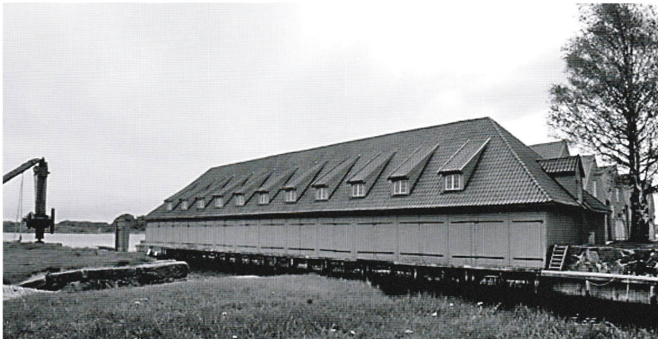
Nordre langvegg med pultarker på taket. Foto: Kjetil Rolseth
