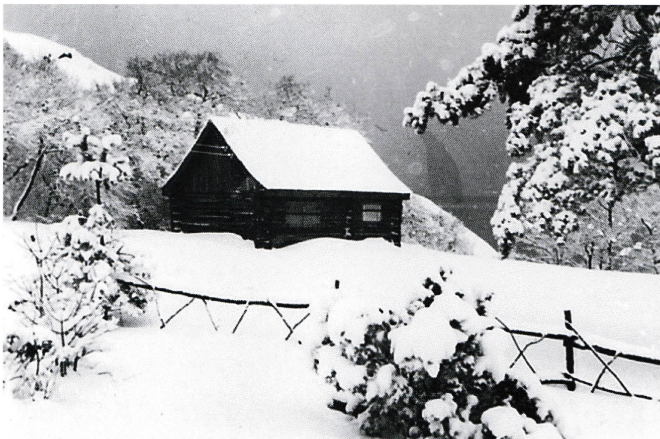
Den gamle tommer bygningen som lå innunder fjellet på Skråvikas nordre del – lenge benyttet som kiosk og lignende under større arrangement. Foto: Rune og Puttes fotosamling.
