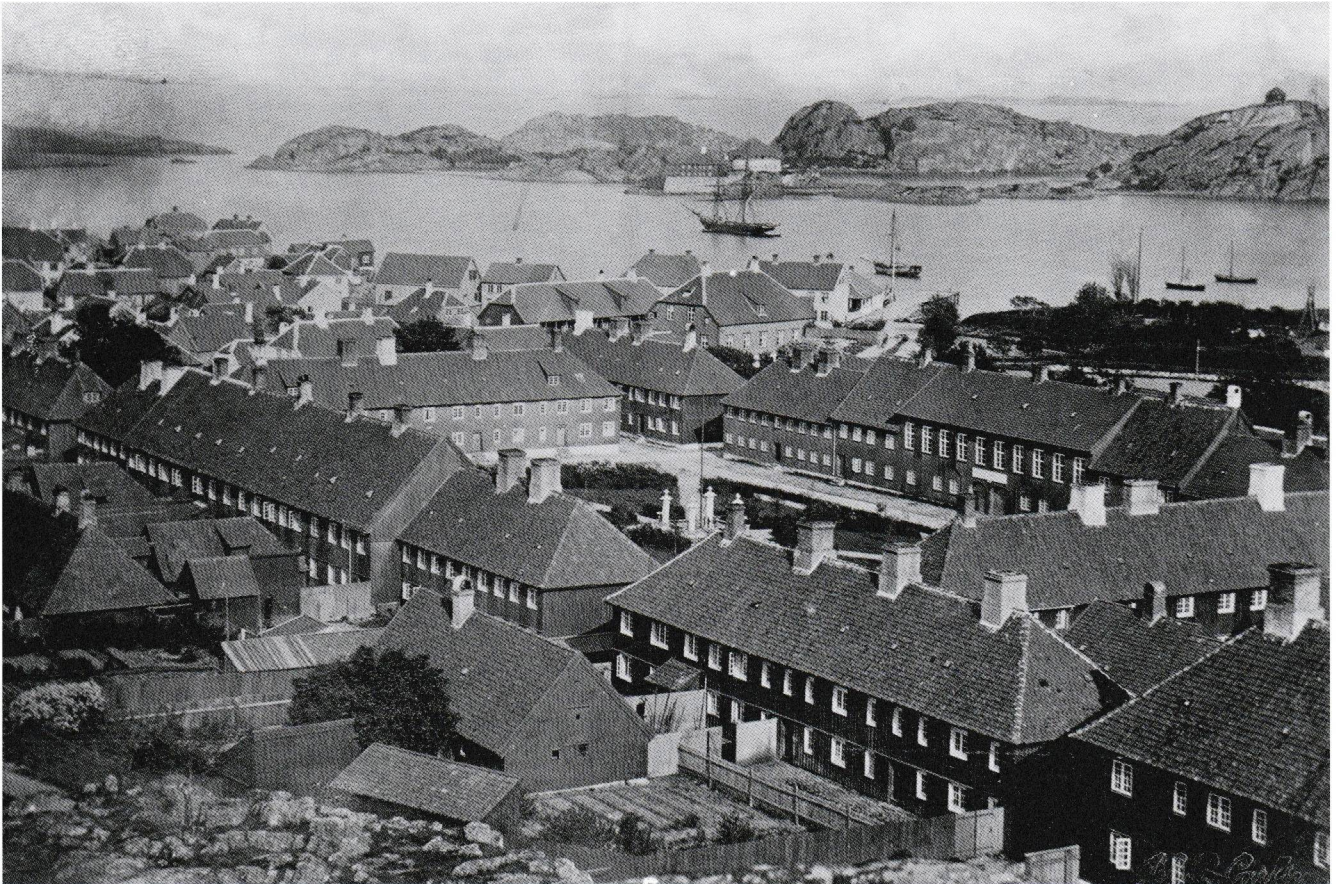
Hvor og hvordan man tenkte seg kirken plassert inne blant barakkene er ukjent - men trolig ble dens endelige plassering kanskje den beste? Foto fra Fredriksvern i 1860. Foto: Rune Sørli's fotosamling
