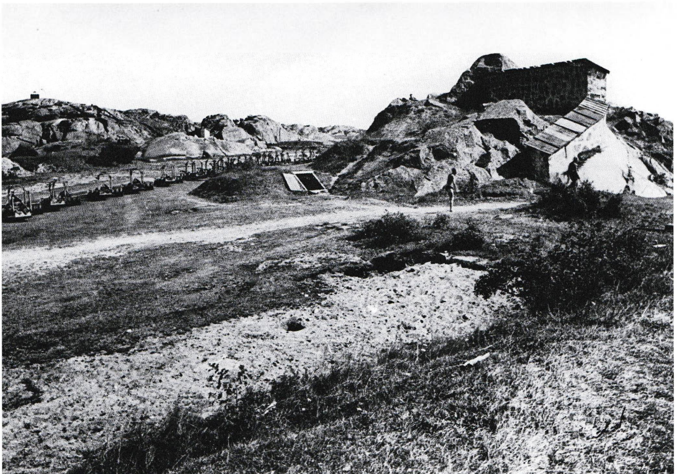
Tilfluktsbunker ute ved Kornin i mai 1945. Foto: Rune Sørli's fotosamling.
