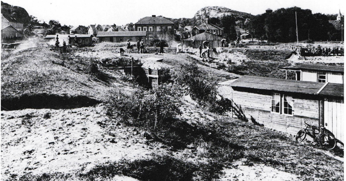
Tyske soldater i fangenskap utbedrer skader på vollene bak garasjeanleggene (teknisk lager) i 1945. Foto: Rune Sørli's fotosamling.
