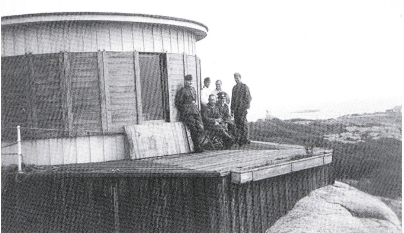
Tyske soldater fra Hærens kystartilleri har tatt den fantastiske hytta til "kommandoøentral" i 1942. Foto: Rune Sørliens fotosamling.
