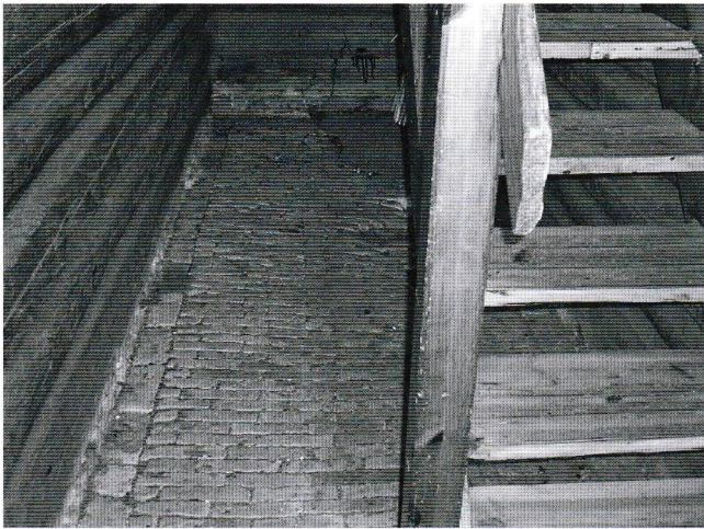
Rester av det opprinnelige mursteinsgolvet i 1. etasje – vestfløyen.
