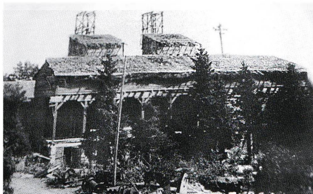
Det store betongblanderhuset, som var i drift døgnet rundt, og som ble delvis drevet av utslitte russiske krigsfanger fra Stavern. Foto: Rune Sørli's fotosamling
