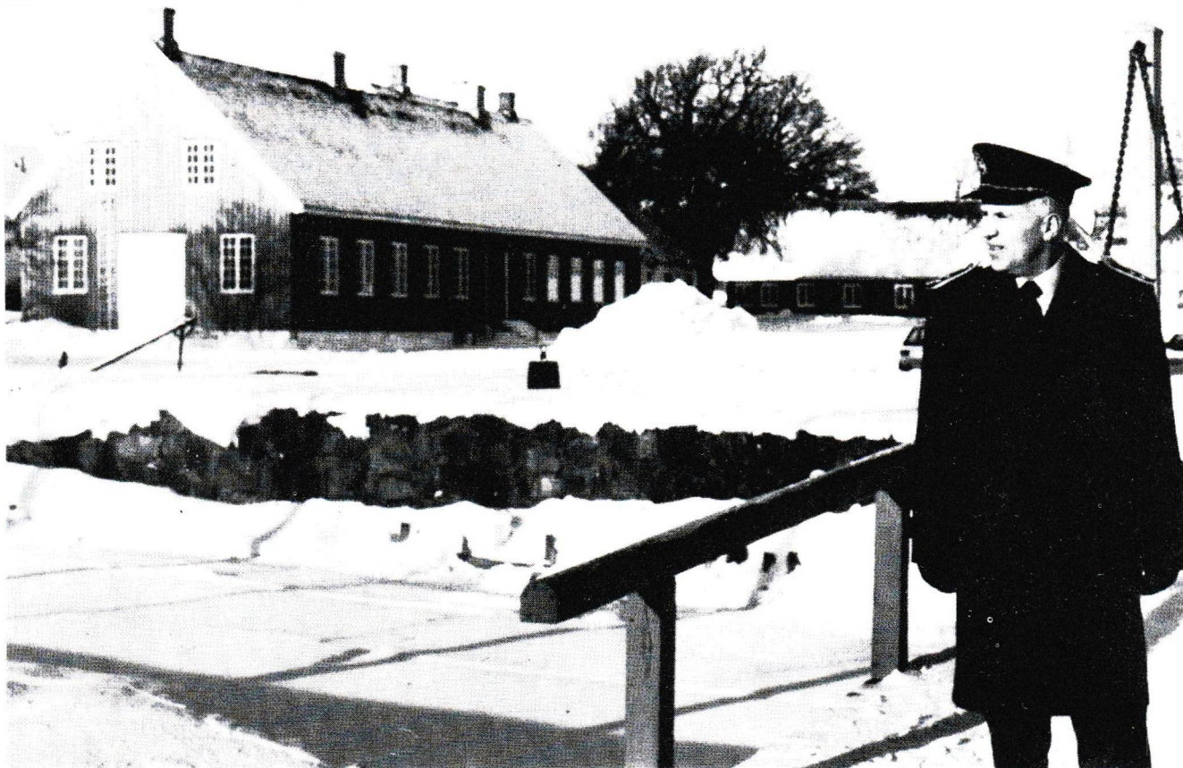
Her ser vi sjefen for Luftforsvarets Offisersskole, oberstløytnant Jarle Hafstad på kanalbrua midt i leiren i Stavern. Til venstre i bakgrunnen befalsmessen, som er uforandret utvendig, men som innvendig har gjennomgått en omfattende oppussing og restaurering.
