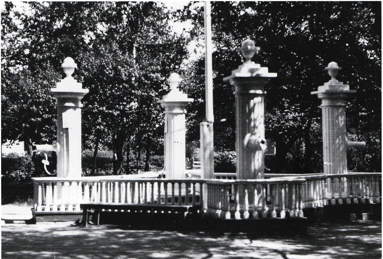
Staverns praktfulle pumpeanlegg - har vært både til nytte og pryde. Foto: Rune Sørli's fotosamling.
