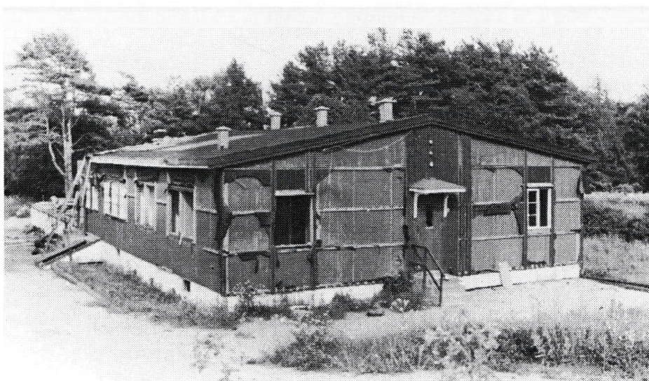
Den østligste av brakkene på Kaken under nedrivning – det var her de gamle tømmerstokkene med brannskade kom til syne – stokker som engang hadde dannet reisverket på Vinkelbrakkka. Foto: Rune Sørli
