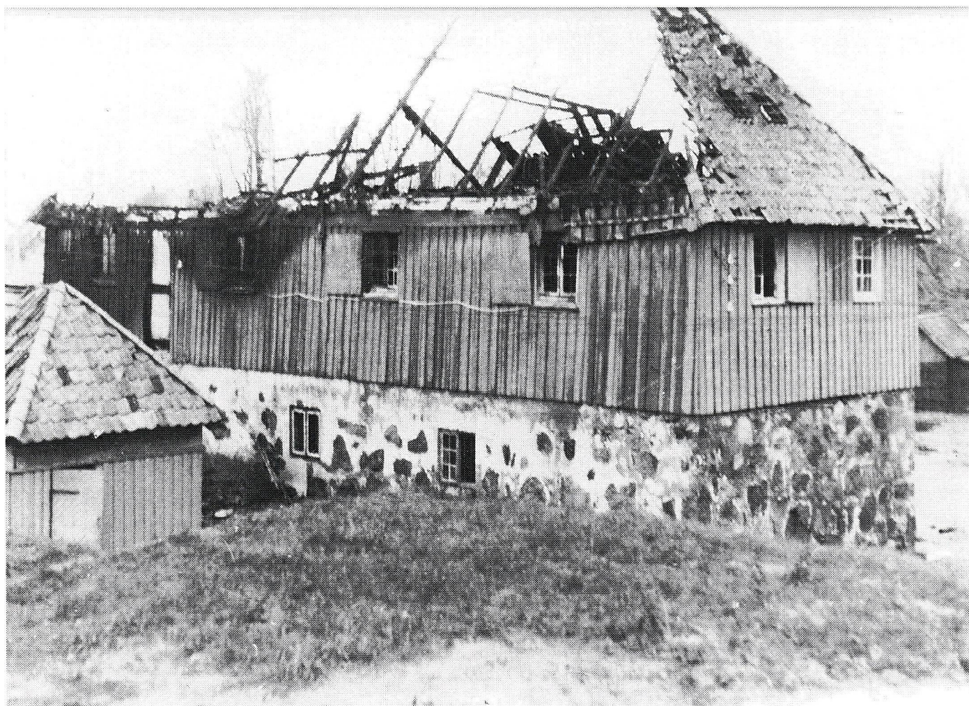
De sorgelige rester etter den forferdelige brannen 8. november 1945 – hvor Vinkelbrakkka ble totalskadet etter at tyskernes provisoriske vedovner hadde antent bygningen. Foto: Vestfold Fylkesmuseum
